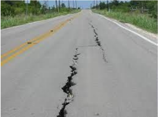
Longitudinal Cracking
