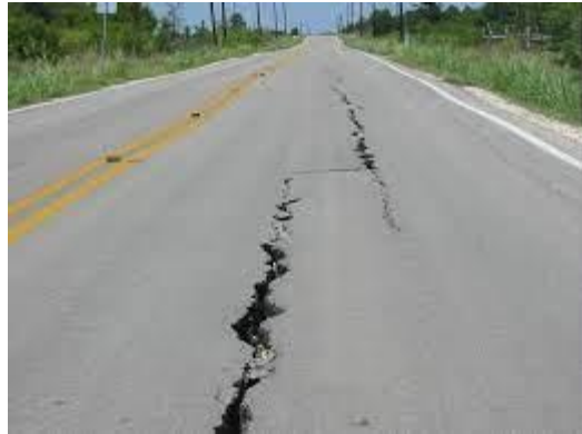
Longitudinal Cracking
